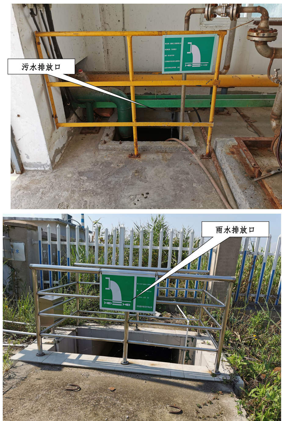
图 4.2-2 雨水排放口及污水排放口设置情况
