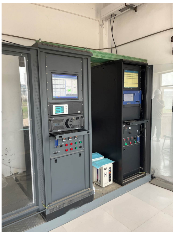
DA001 排气筒废气在线监测（颗粒物、SO 2 、NO x 、CO、氯化氢、非甲烷总烃）
