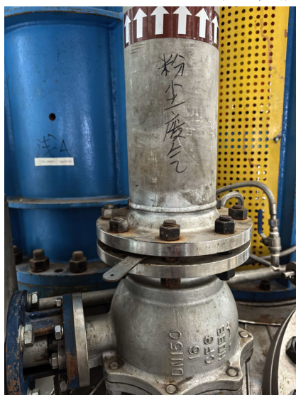
滤网除尘（管道内）
